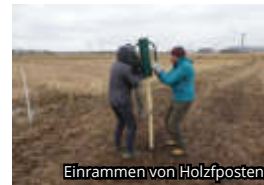
Einrammen von Holzposten
